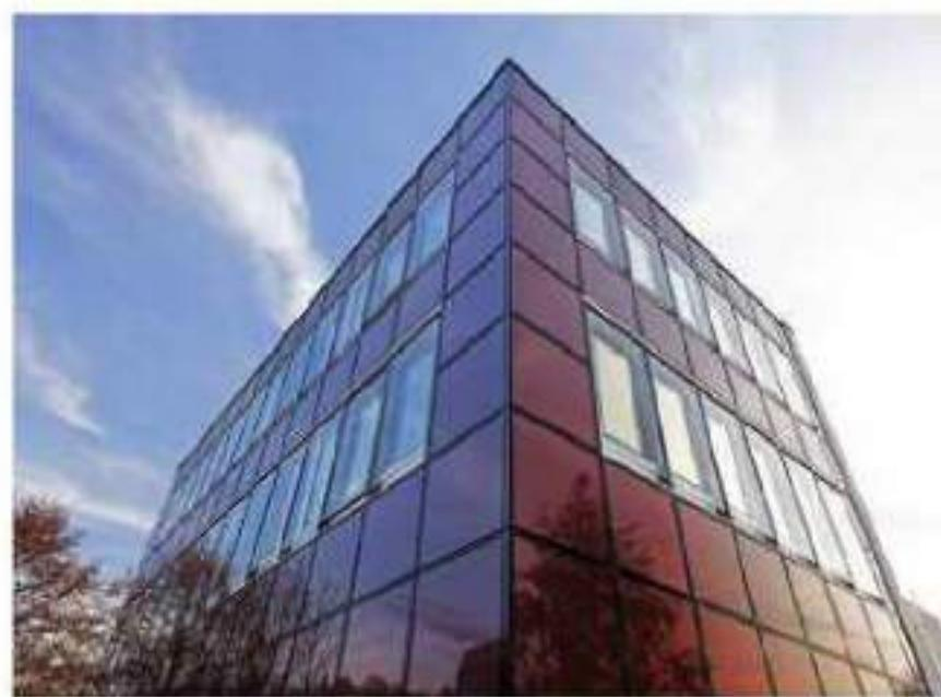
**L'ISTITUTO IFT DI ROSENHEIM È STATO RISTRUTTURATO SU PROGETTO DELLO STUDIO DI ARCHITETTURA GUGGENBICHLER + WAGENSTALLER; CARATTERISTICA PECULIARE DELLA STRUTTURA È LA FAZZIATA VERTICALE CON MODULI FOTOVOLTAICI PROSOL TF DI SCHÜCO**
